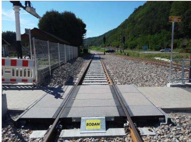
Bei einem evtl. Ausbau der BODAN-Rillenfüller (FWC) und erneuten Wiedereinbau sind die Schrauben auf Schäden zu prüfen und ggf. zu ersetzen. Wir empfehlen, diese immer zu erneuern.
