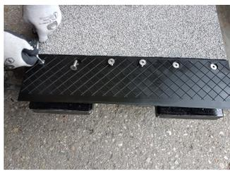
1. Bei Anlieferung der Rillenfüllerplatten sind die Rillenfüller vormontiert. Vor der Montage der Platten, sind die Rillenfüller zu demontieren. Die Schrauben sind mit Anti-Seize-Spray (Spezialpaste gegen Korrosionsschutz, Festfressen) behandelt. Eine neuerliche Behandlung bei der Montage auf der Baustelle ist erforderlich.
