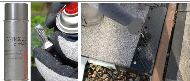
2. Alle Schrauben per Hand mit Innensechskant-schlüssel (Inbus) herausdrehen. Vorsicht bei Verwendung eines E-Schraubers (das Gewinde der Schrauben und der Ösenmuffen darf nicht beschädigt werden!) Schrauben mit Anti Seize Spray Spezialpaste oder gleichwertigem besprühen.
