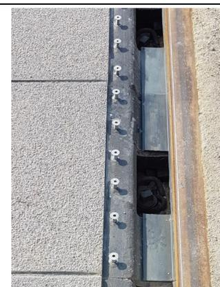
4. Sollte das Gummiprofile PIO-F im Bereich der Kleineisenaussparung nicht offen sein, kann dieser Bereich bei der Montage ausgeschnitten werden. Achtung: Vor Schnittverletzungen schützen (persönliche Schutzausrüstung verwenden!). Die Tätigkeit kann mit einem Catlernesser unter Berücksichtigung des Arbeitsschutzes für die Gerätschaften auch durch eigenen Wartungstrupp der Bahnbetreiber durchgeführt werden.
