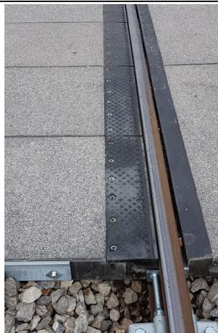
6. Innensechskantloch mit Füllmaterial ADHESEAL oder Gleichwertigem ausfüllen (dient der Schraubensicherung und zum Schutz vor Verschmutzungen).
