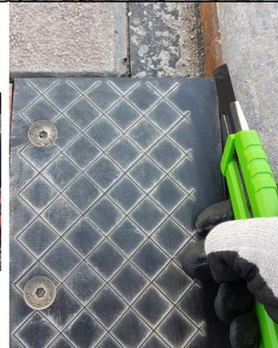
7. Spaltmaß 1 mm von Schiene zu BODAN-Rillenfüller FWC prüfen. Sollte BODAN-Rillenfüller FWC bei der Schiene (speziell bei Gleisradien) anstehen, ist dieser mit einem Catlerrmesser oder Schleifgerät unter Berücksichtigung des Arbeitsschutzes für die Gerätschaften zu kürzen (Spaltmaß ca. 1 bis 2 mm) Diese Arbeiten können auch durch eigenen Wartungstrupp der Bahnbetreiber durchgeführt werden.
