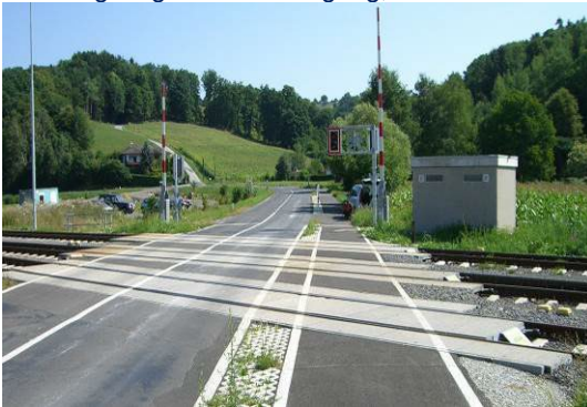
Foto 16 Fertig eingebauter Übergang, Österreich
