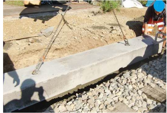
Foto 7 Einbau Fundamentbalken WUB
