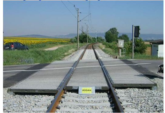
Foto 17 Fertig eingebauter Übergang, Deutschland
