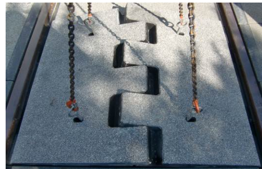
Foto 4 Die beiden Platten werden in Montageposition gebracht
