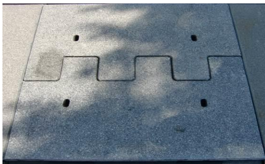
Foto 5 Die beiden Platten in eingebautem Zustand ohne Verschlussstopfen
