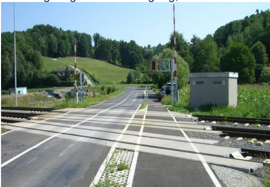
Foto 16 Fertig eingebauter Übergang, Österreich
