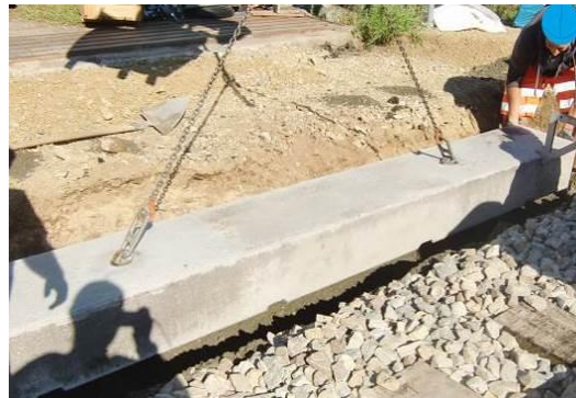
Foto 7 Einbau Fundamentbalken WUB
