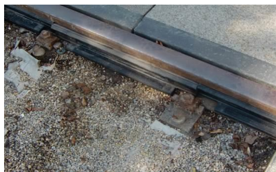
Foto 4 Die beiden Platten werden in Montageposition gebracht
