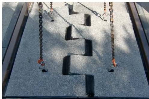
Foto 4 Die beiden Platten werden in Montageposition gebracht
