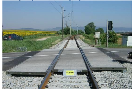
Foto 15 Fertig eingebauter Übergang, Österreich
