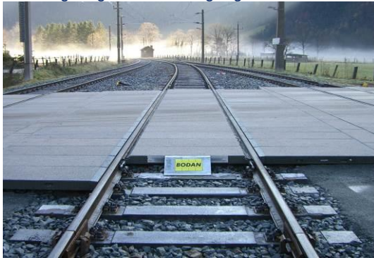
Foto 14 Fertig eingebauter Übergang, Österreich
