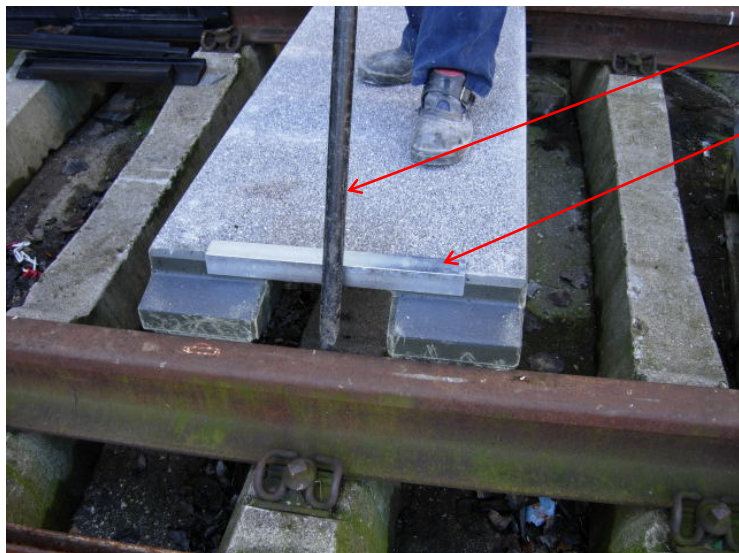
Bild 7; Demonstration des Werkzeuges - Keilmontagehebel
