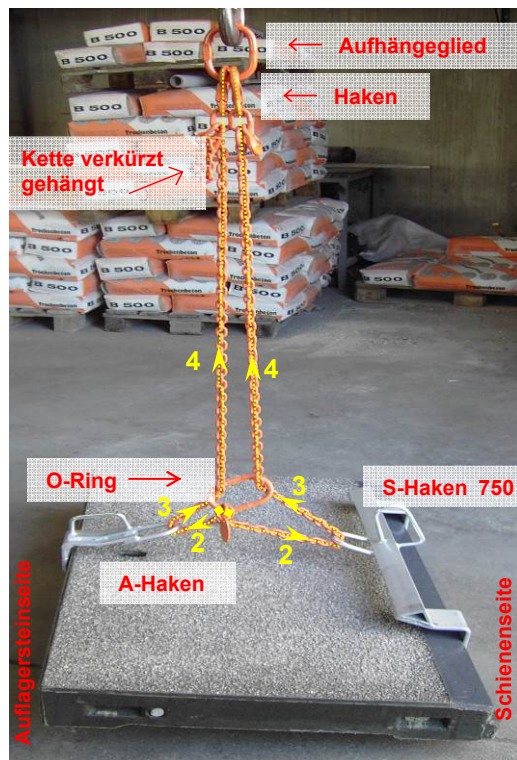
Bild 3; Demonstration des Werkzeuges für BODAN-Außenplatten 750 / 950
