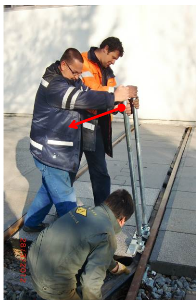
Bild 7; Demonstration des Werkzeuges - Keilmontagehebel
