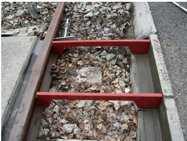
Bild 9; Demonstration des Werkzeuges - Distanzlehre AP 750
